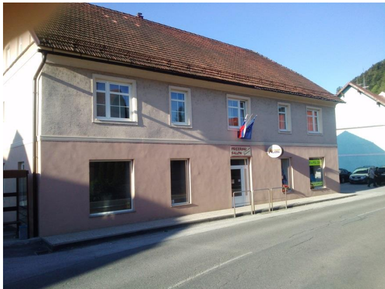
Slika 22: Pogled na občinsko stavbo – prostori občine Mirna
